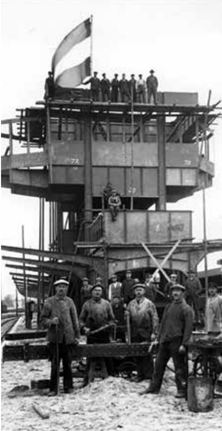
Groningen. Perron 3, seinhuis in aanbouw (2)(1928).
