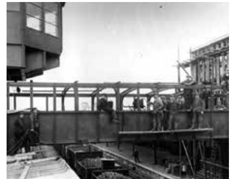
Groningen. Perron 3, seinhuis in aanbouw (1)(1928).
