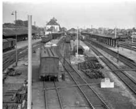
Leeuwarden. Begin elektrificatie emplacement (1952).
