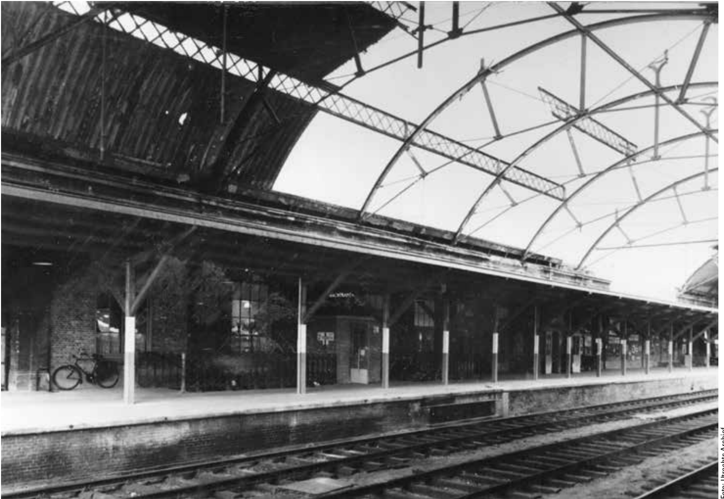
2. Sikkelspanten van overkapping station Arnhem (1867) nadat het in de Tweede Wereldoorlog beschadigd is geraakt.
