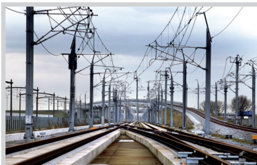
Figure 2: Zevenbergschen Hoek junction (Photo: Rijkswaterstaat HSL-Zuid / Ton Poortvliet)
