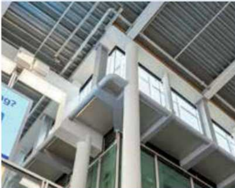
Gootconstructie bij de Katreinetoren.
