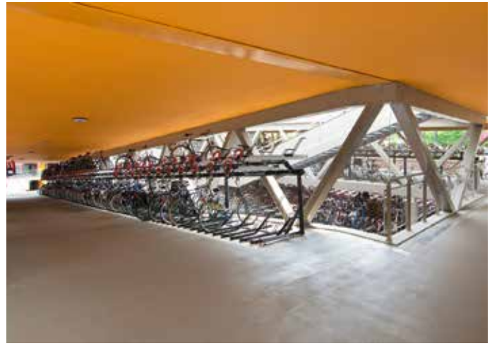
Door de hoogte van het vakwerk zijn grote overspanningen mogelijk.
