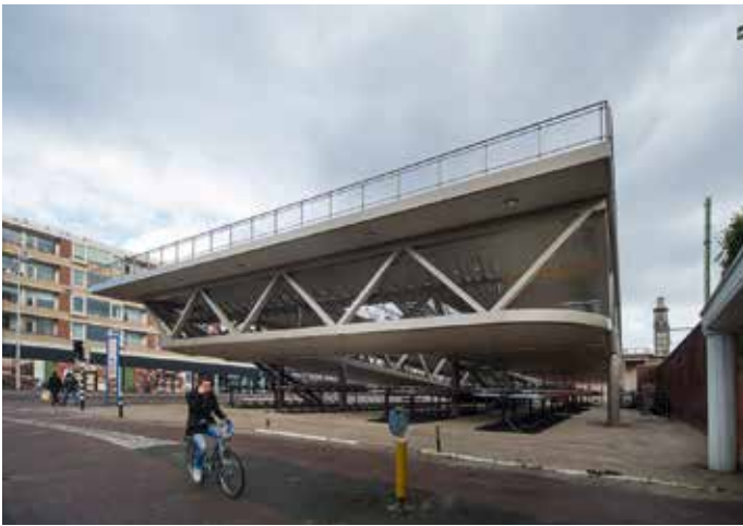
Het doorlopen van de vakwerken in de kopgevels draagt bij aan de stijfheid.
