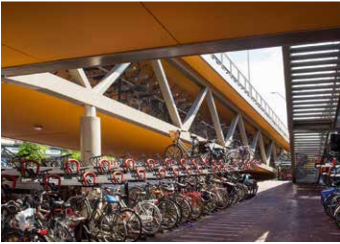
De constructie heeft verdiepinghoge stalen vakwerkliggers.
