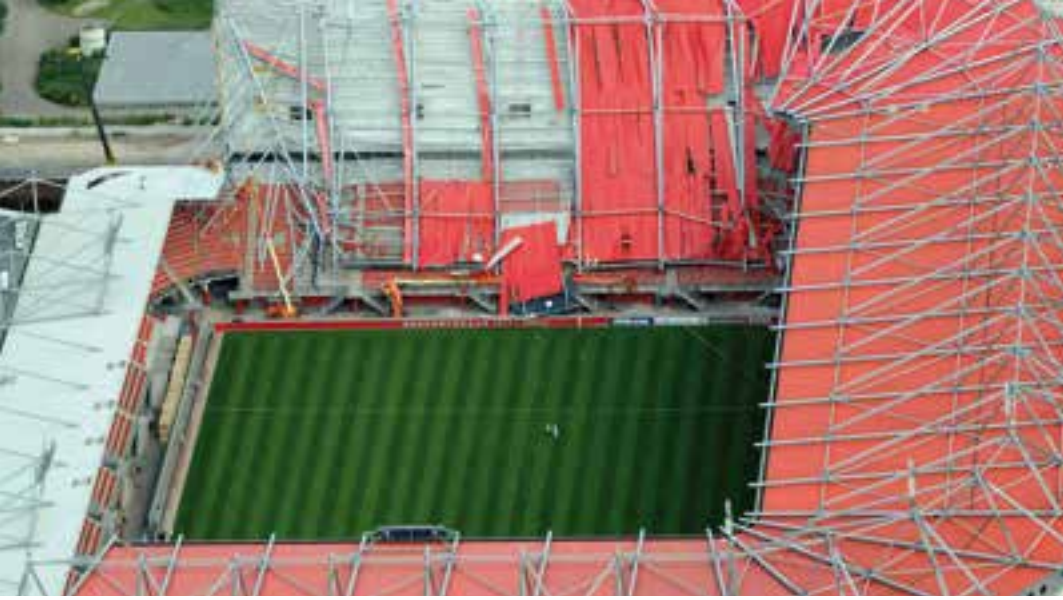
10 Ingestorte tribune van het stadion van FC Twente
