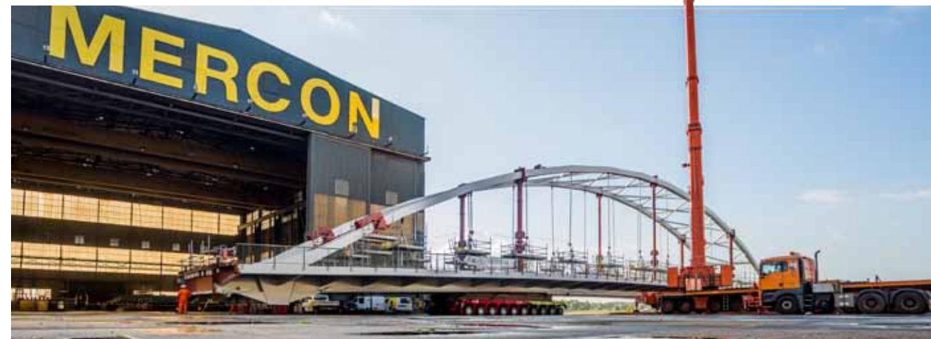
De hoofdoverspanning weegt ruim 1.000 ton.
