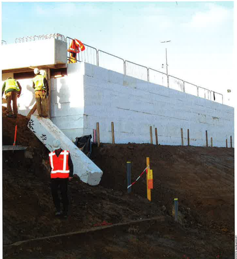
Opbouw van de wegophoging met EPS-blokken met verticale zijkant.
