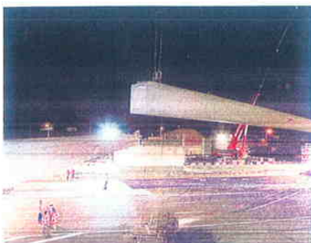
Montage van de 54 meter lange prefab-kokerliggers.
