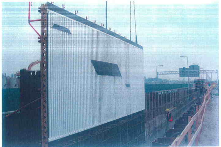
Bekistingsschot van de wand met cannelure- en vogelpatroon.
