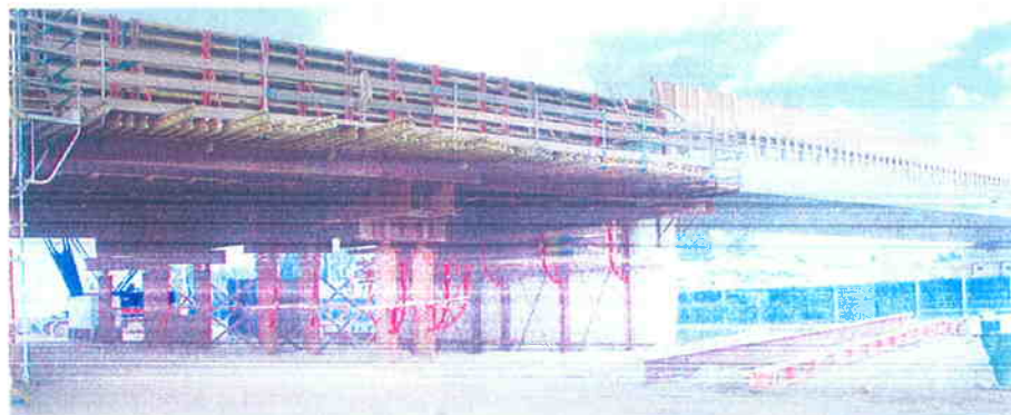
Ondersteuningsconstructie van het in-situ dek.
