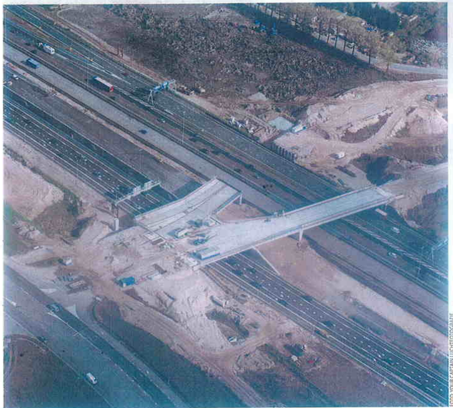
Vanuit de lucht is de bijzondere vorm van het Marinus van Tyrusviaduct het best te zien.
